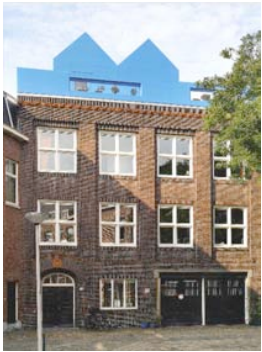
3 etg. i tegl med "noe oppå"
