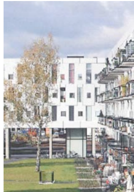
gjennomgang under huset til grøntareal
